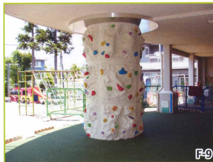
神奈川 いまいずみ保育園 (円筒形、直径1.4m カーブパネル12枚使用)
